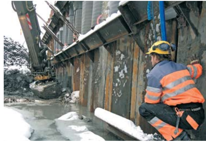
Forsiktig utgraving av gropa mot spuntene mot eksisterende spor. Vidar Warlo fra Spesialprosjekt følger med og bistår maskinføreren.
