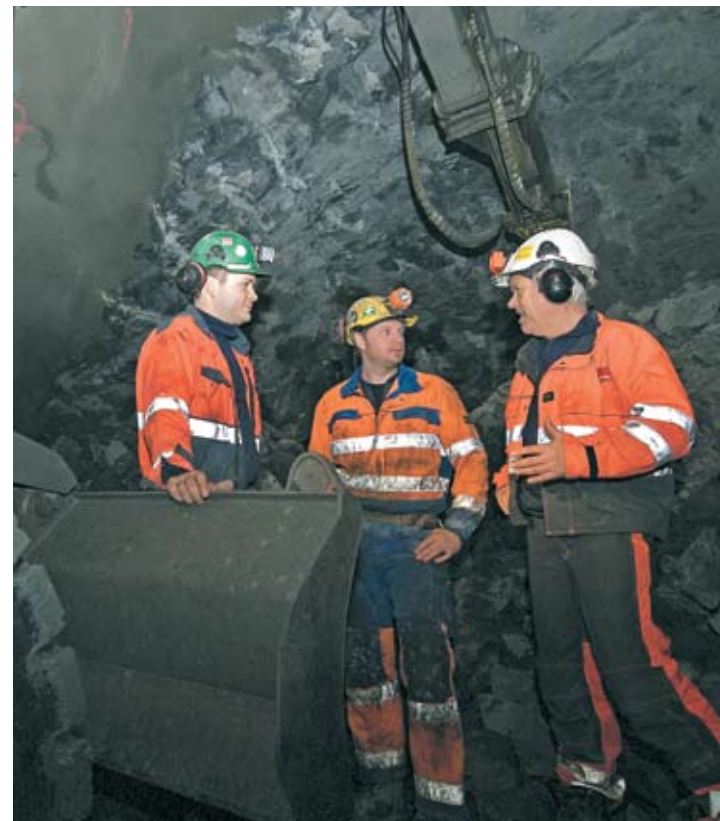
Pigging og lasting på stoffen. Fra venstre: Bas Ola Marius Husaas, tunneldriver Eivind Stendal og formann Nils Ove Gjeldokk vurderer om de skal pigge eller skyte bort en knøl i hengen.
