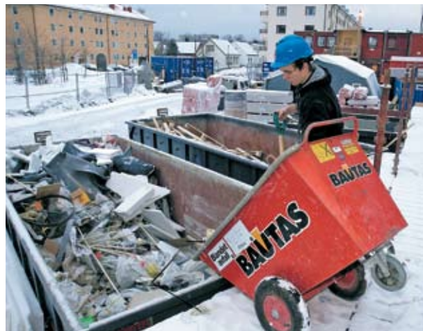
Systematisk kildesortering er igangsatt på Veidekkes initiativ. "Arvidene" er merket med hvilken type avfall de skal brukes til og hvilken etasje de tilhører.
