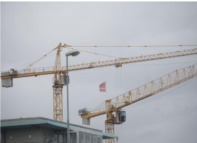
Figur 1 Illustrasjon av antikollisjonssystem hvor flere tårnkraner har felles soner.
